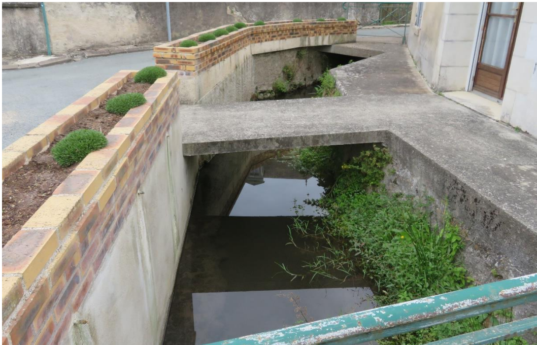
Figure 1 - Partie canalisée du ruisseau de la fontaine Bernard passant dans le bourg
